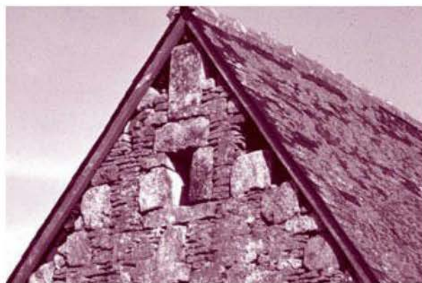
Raccord entre les murs et la toiture.
