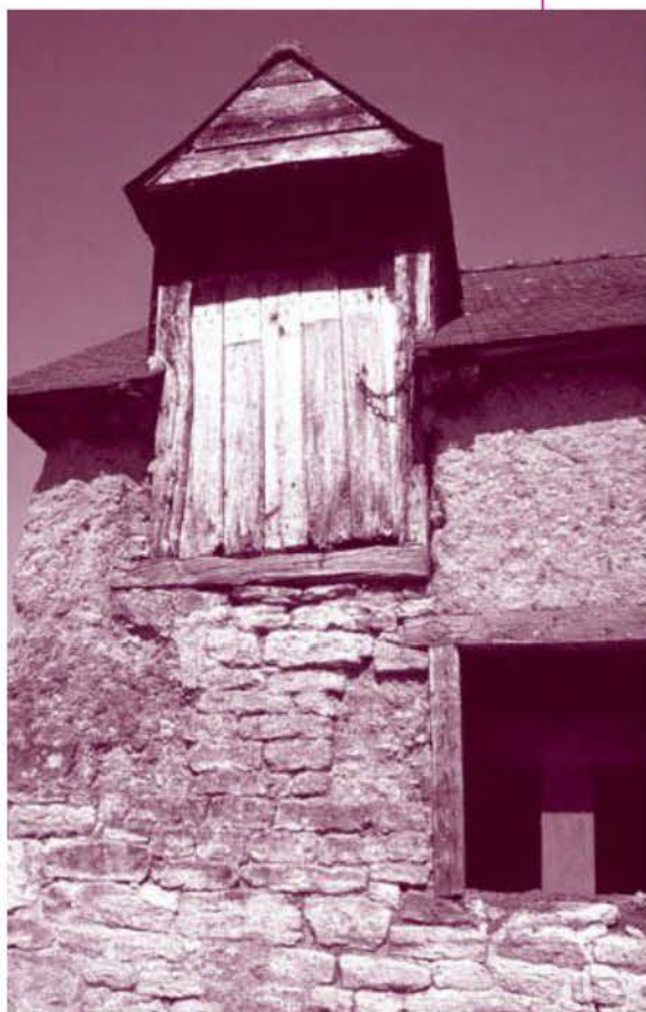
L'utilisation, au niveau des combles, d'un matériau de construction différent de celui du niveau inférieur est très fréquente dans le bâti rural ancien.
