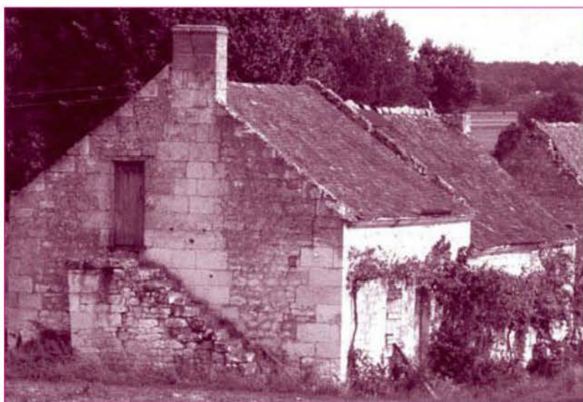
Pour des raisons d'encombrement, l'accès aux combles se fait très souvent par le pignon.
