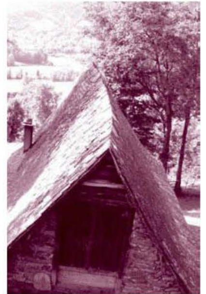
Toit plat de tuiles rondes (ici en Provence) et toit de lauzes à forte pente (là dans les Pyrénées) répondent aux modalités de la mise en œuvre des matériaux de couverture.
