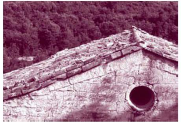
Toit plat de tuiles rondes (ici en Provence) et toit de lauzes à forte pente (là dans les Pyrénées) répondent aux modalités de la mise en œuvre des matériaux de couverture.
