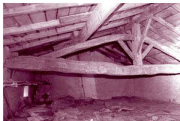
Zones déclassées dans un comble à 30°.
