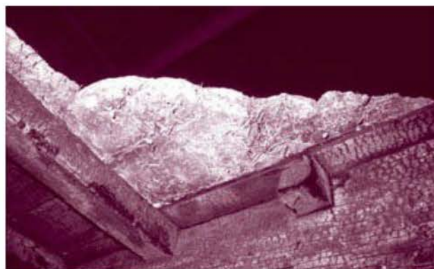
Un sol de terre battue au niveau des combles améliore largement l'isolation thermique et phonique des pièces sous-jacentes.
